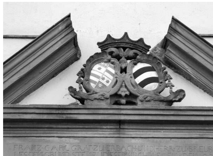
Allianzwappen Isenburg-Büdingen/Erbach im Sprenggiebel des Renaissanceportals der ev. Kirche in Rimbach
