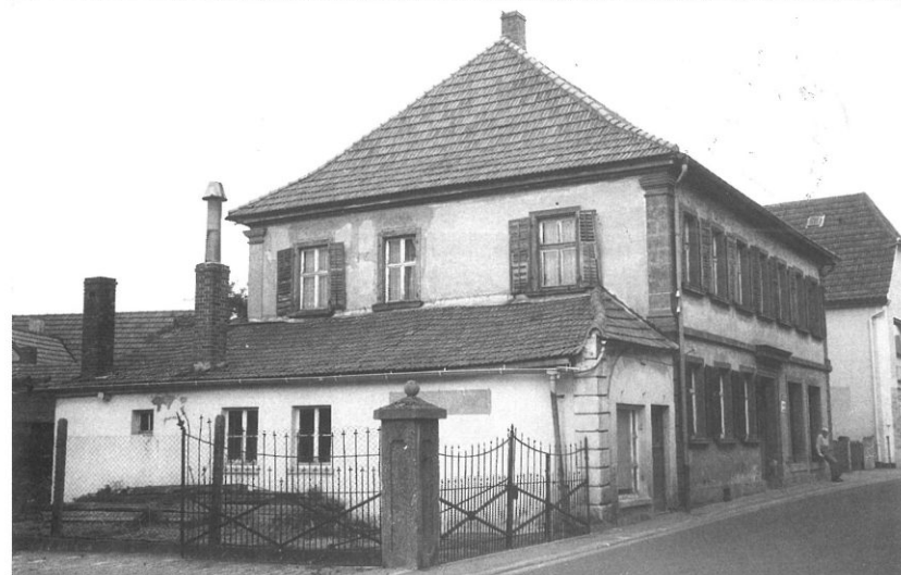
Einiges von ihrer ursprünglichen Atmosphäre strahlt auch heute noch die Rechtsanwalt-Krauss-Straße aus. Die Häuser wurden durchwegs in den Jahren 1820—1840 errichtet. — Unten Haus Nr. 78 d, u. a. im Besitz der Familie Levor. Ein Verwandter dieser Familie in Bayreuth half mit, einen finanziellen Grundstock für die Schuhfabrik Pretzfelder/Rixinger im Jahre 1912 zu legen.
