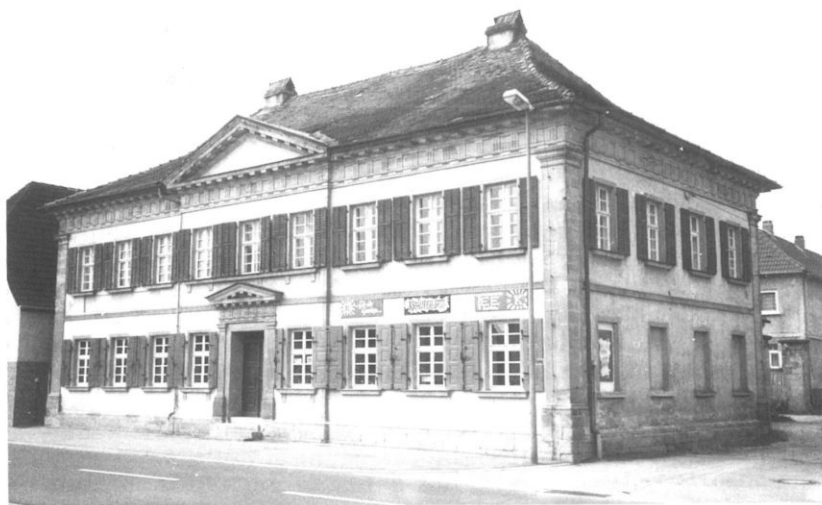
Haus Nr. 72, Wohn- und Geschäftshaus der Familien Mack und Seeligsberg, 1832/33 im klassizistischen Stil von Georg Zeuß erbaut, möglicherweise nach Plänen des Leo von Klenze.
